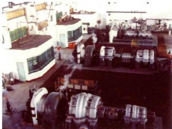
1978年由杭州汽轮机厂为上海吴泾化工厂年产30万吨合成氨装置提供的6种10台工业汽轮机在沪投产运行成功。
