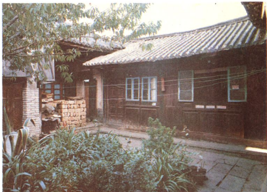
保山市卫生防疫站旧址检验室一角。 (永昌镇朱紫街)，住房及办公用房计16格， 366.8 m 2 。
