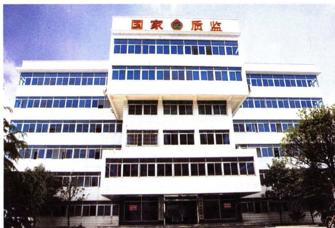
长沙县质量技术监督局办公检测大楼(1996年6月投入使用,2004年1月在原4层大楼基础上增加2层,建筑面积共1760平方米)
