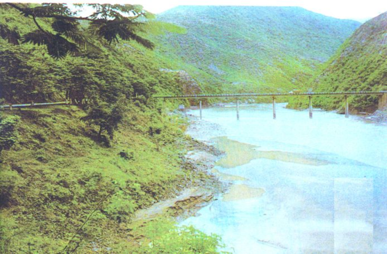
昆洛公路上的元江大桥，1969年9月建成。
