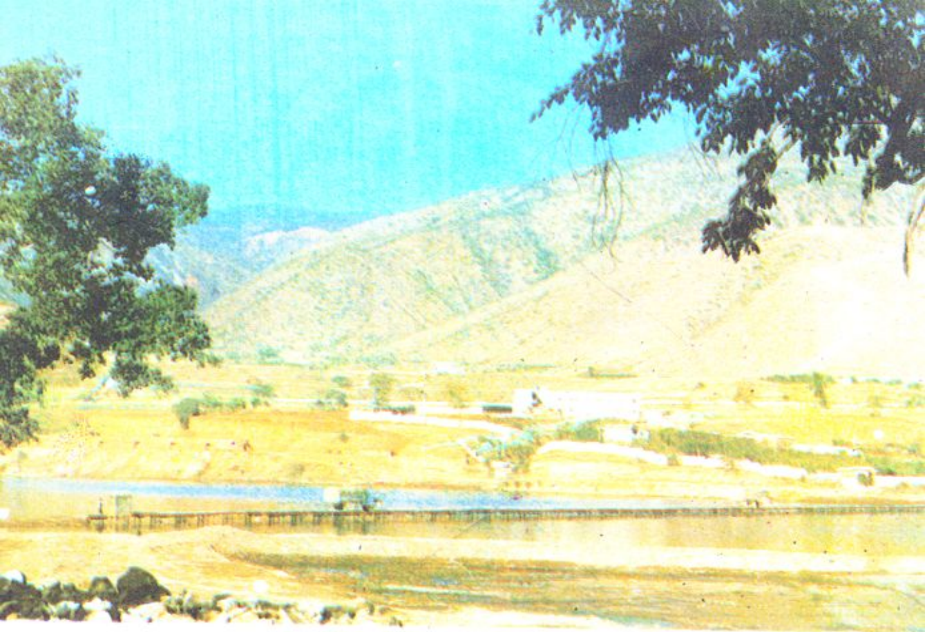
澧江大桥未建成之前漫林糖厂榨季临时架设的澧江简易便桥
