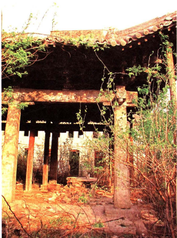
阳城固隆村泽城汤帝庙献殿(舞楼)明万历重修
