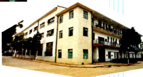
铁芯车 间外景
