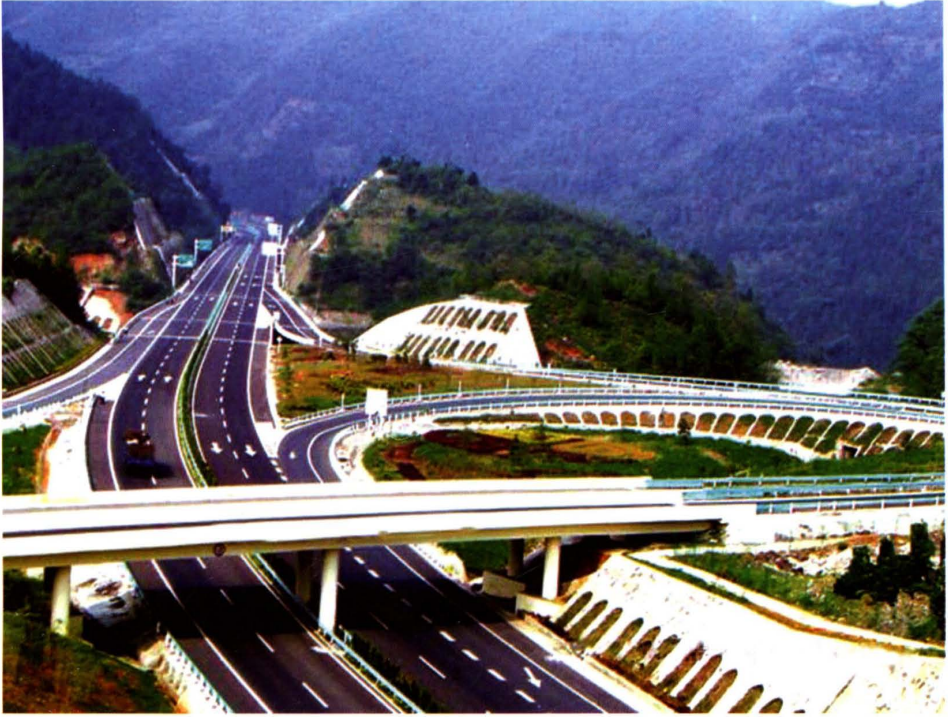
沪瑞高速公路县城进出口（2012年摄）。
