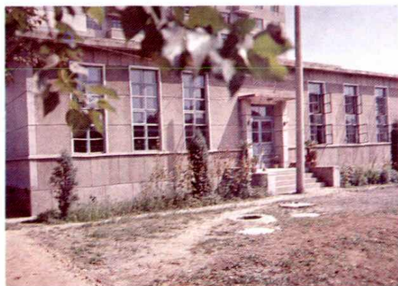
▼ 三台子变电所
