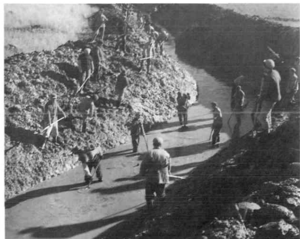
开挖绰霍尔干渠
