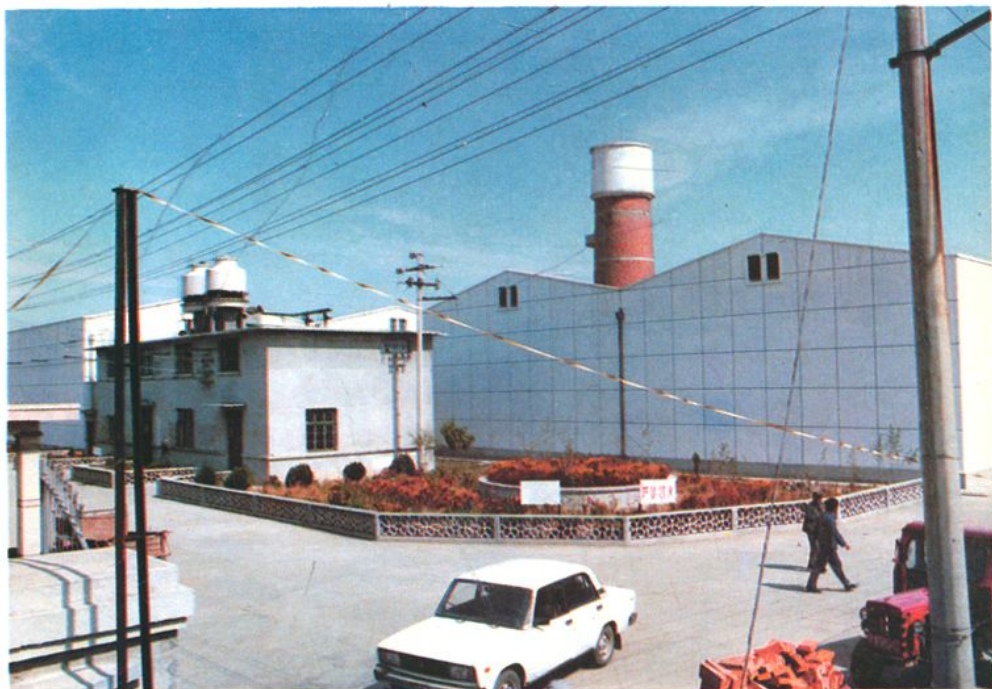
莱阳县供销社冷风库
