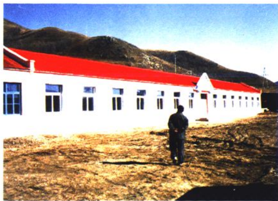
③ 兴安盟阿尔山市五岔沟小学学生宿舍。
