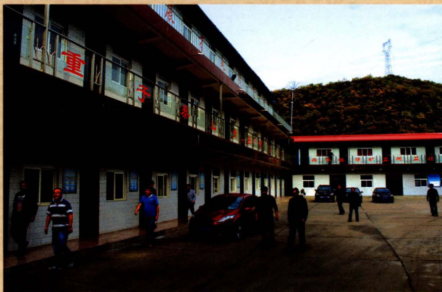
2009年西华镇 煤矿修建的办公楼
