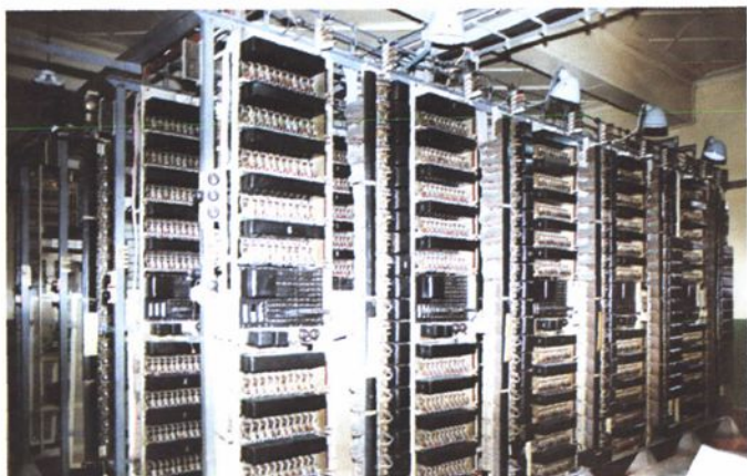
▲ 1962年安装在大理州邮电局的1000门步进制自动电话设备。
