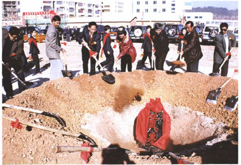
▶ 1998年12月28日,大理电信枢纽大楼奠基仪式。
