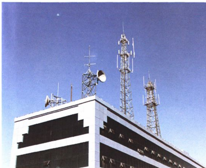
◀ 移动电话及长途数字微波天线铁塔。
