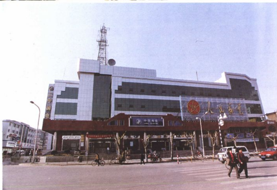
▶大理州电信综合大楼。
