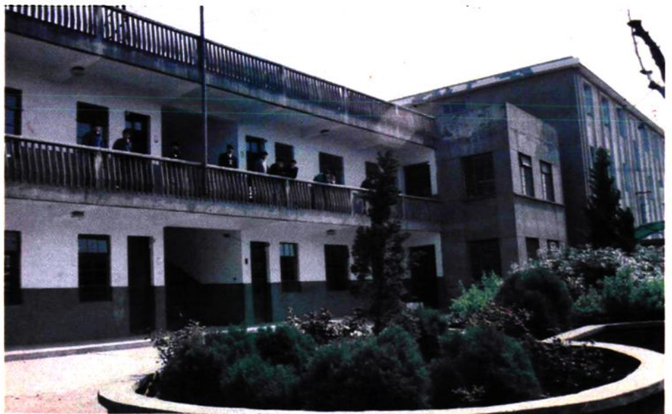
▼ 涟水县卫生进修学校教学楼
