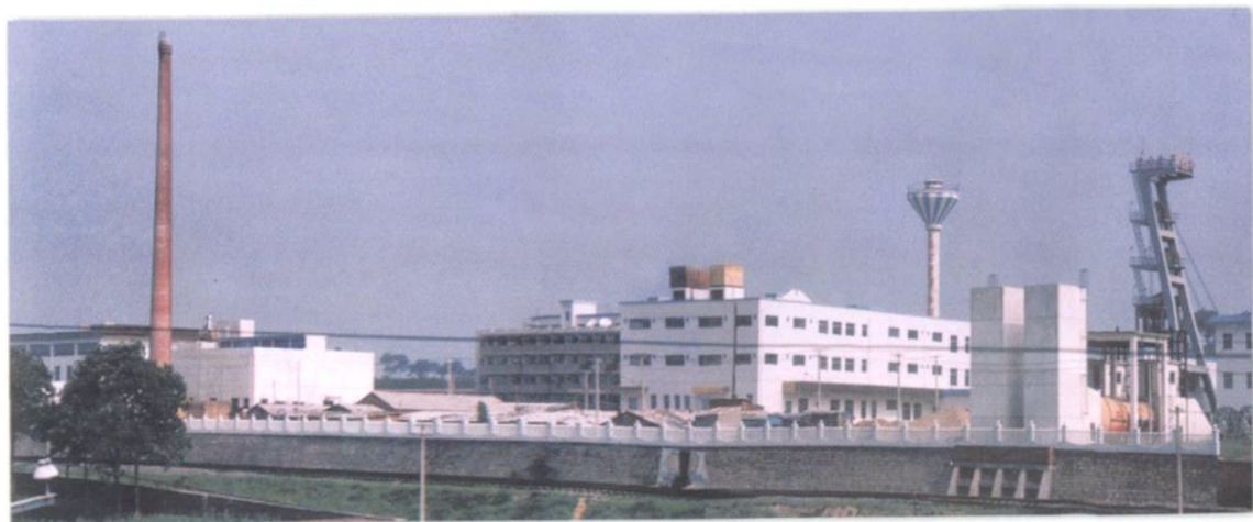
▲ 正在建设中的梁北一号矿井
