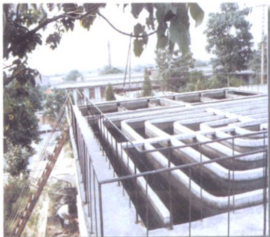
◀ 中峰吕沟煤矿的污水净化系统
