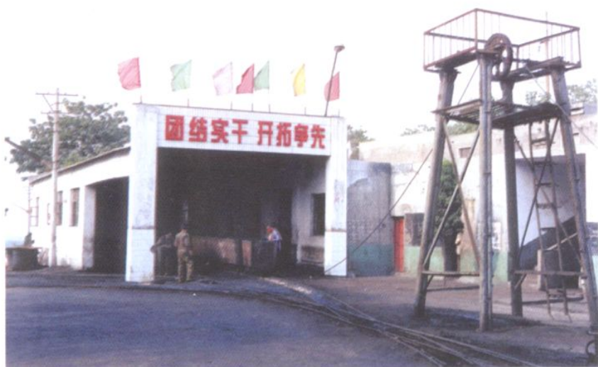
◀ 梁北镇郭村煤矿主产区一角
