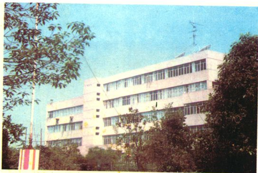
教 学 实 验 大 楼
