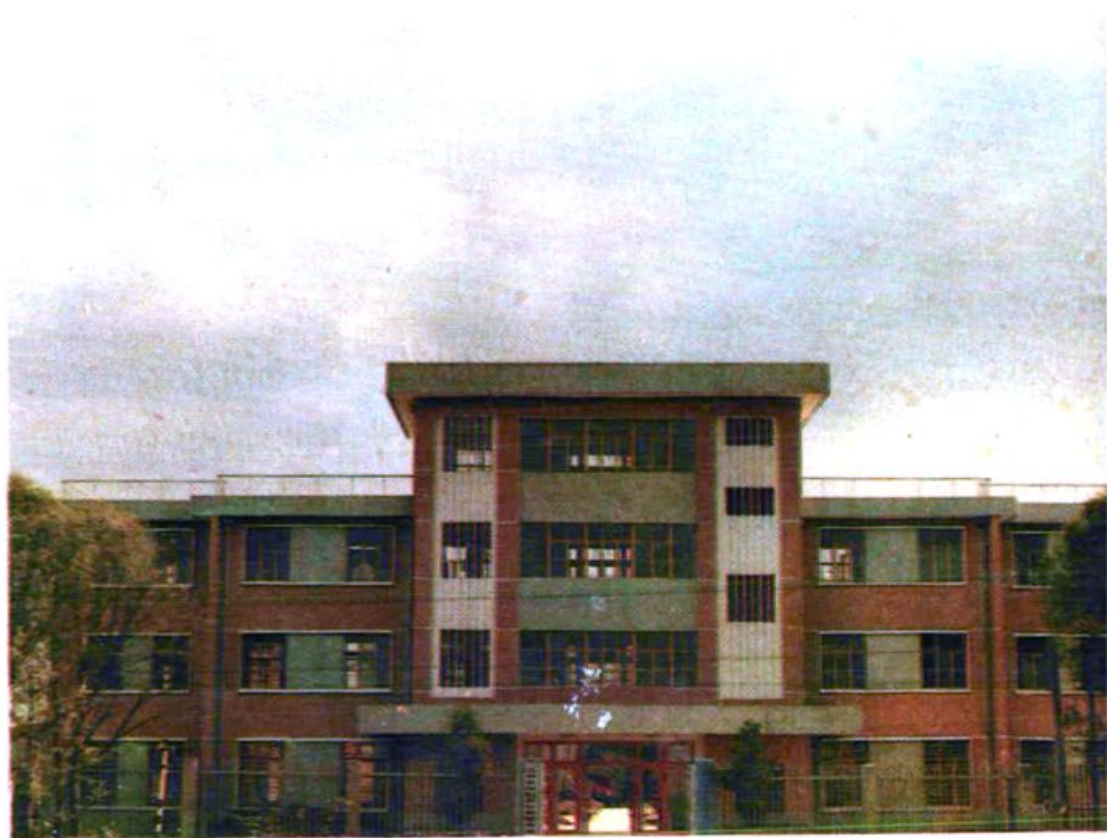
海门县公路管理站位于海门镇东南首。
