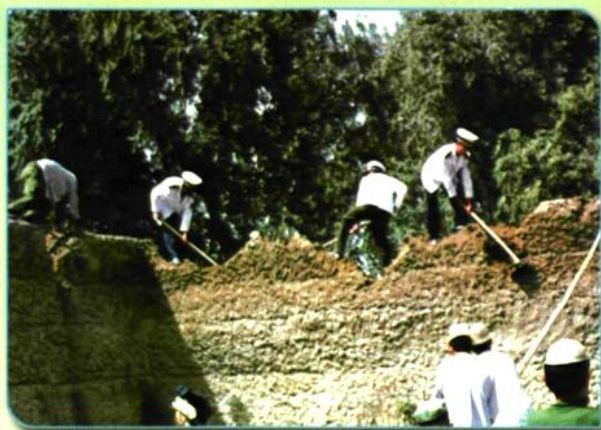
拆除违法建筑
