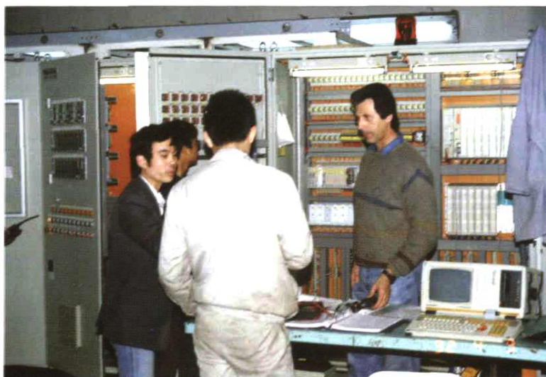
进口设备安装现场
