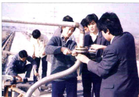
液体化工产品进口施工现场
