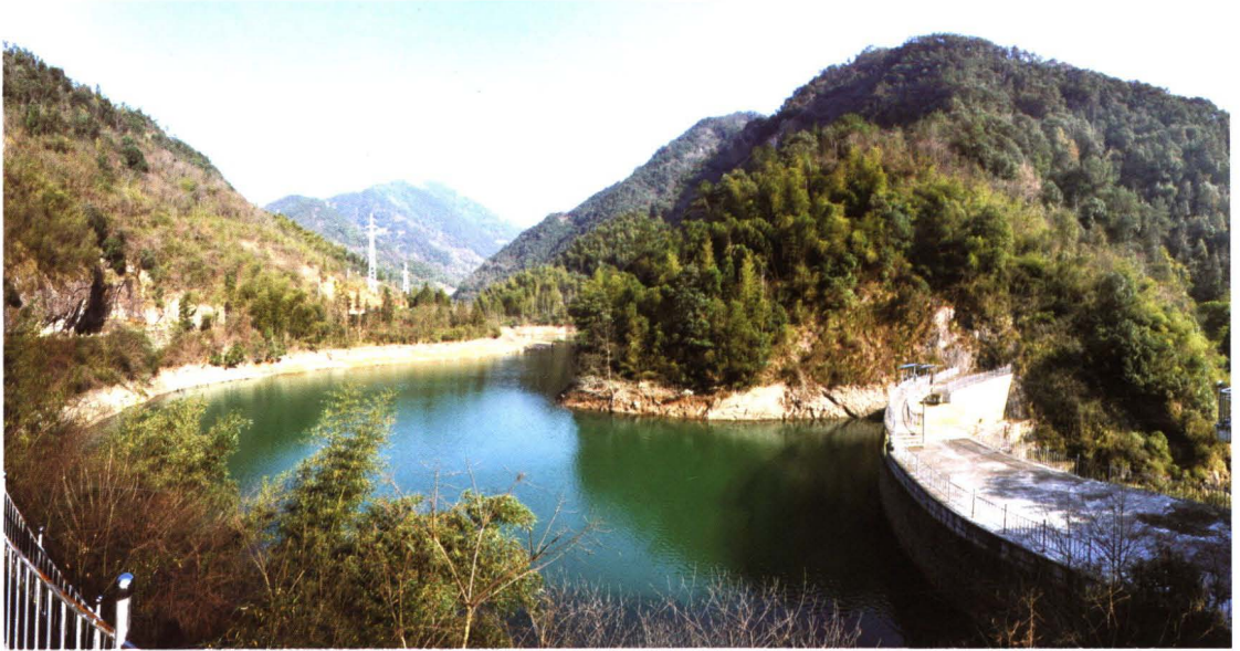
境内唯一的浆砌块石拱坝(石峡水库)
