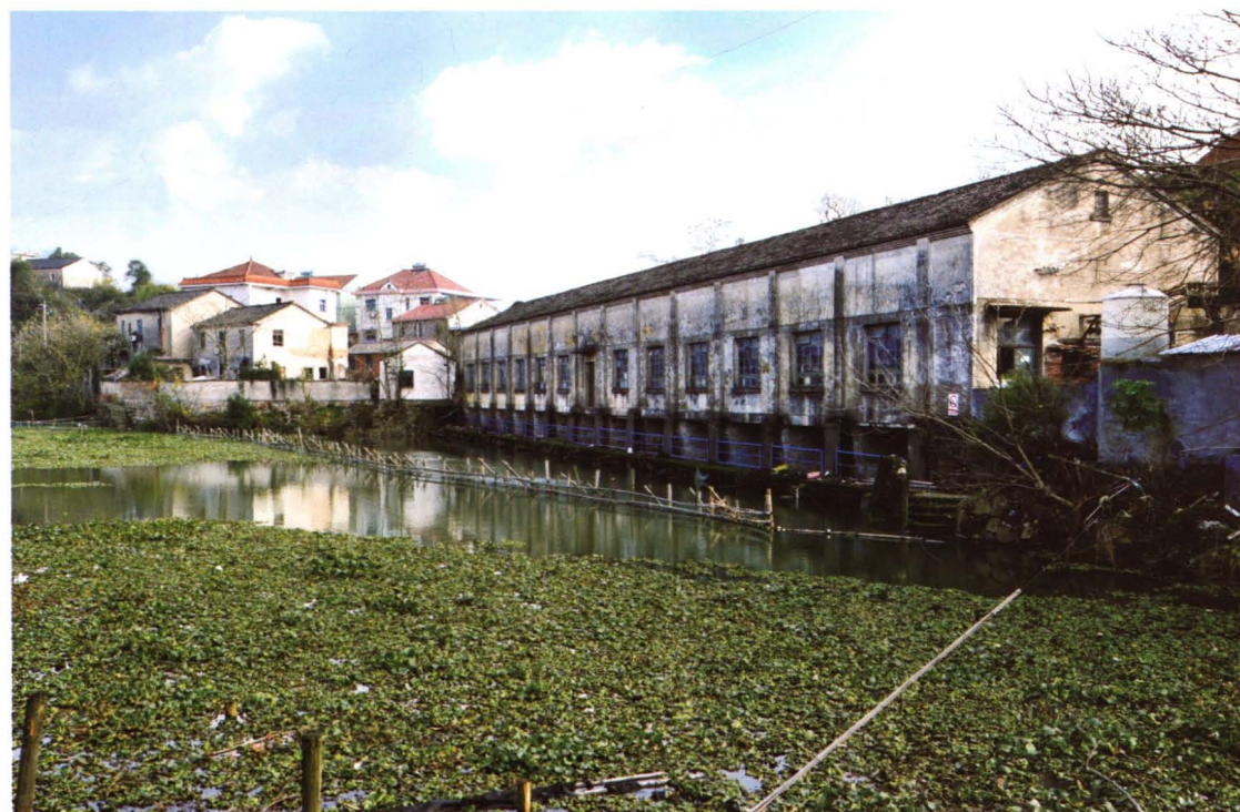
白塔湖老电排站
