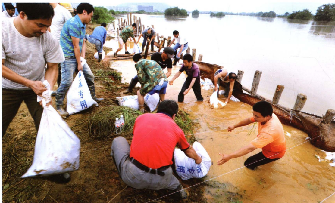
枫桥江路家桥段抗洪抢险现场
