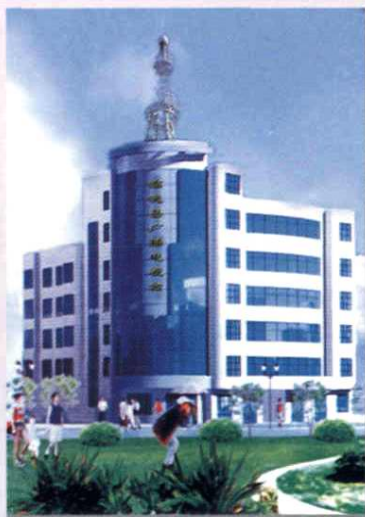
县广播电视大楼
