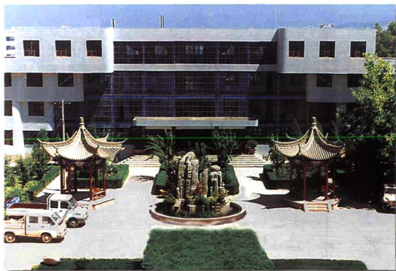
县政府机关办公楼
