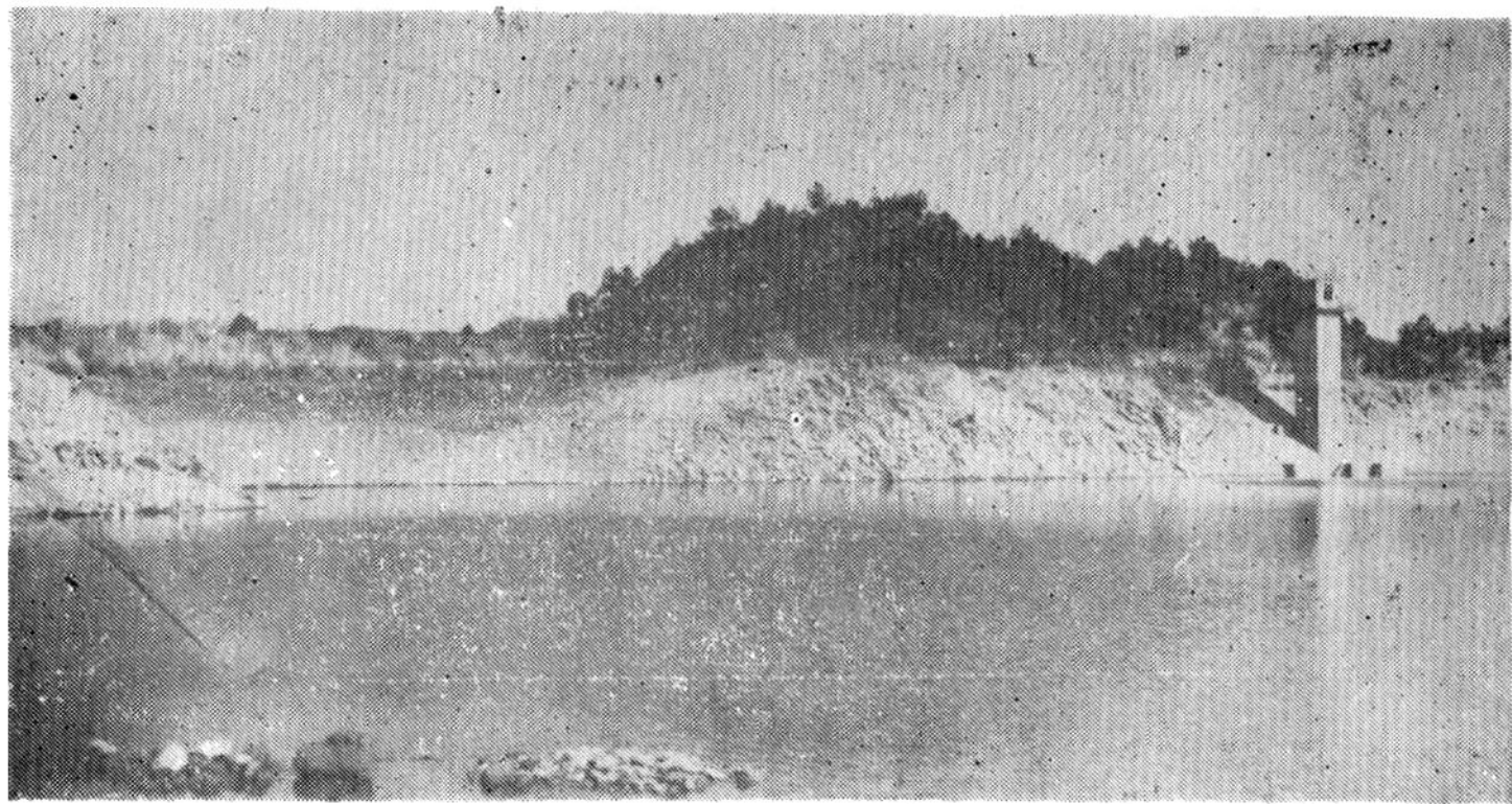
10、仕源水库大坝、泄水闸
