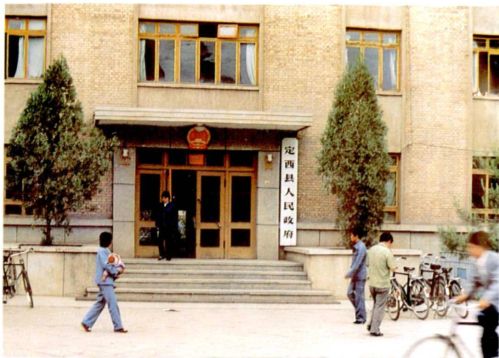
定西县人民政府办公楼
