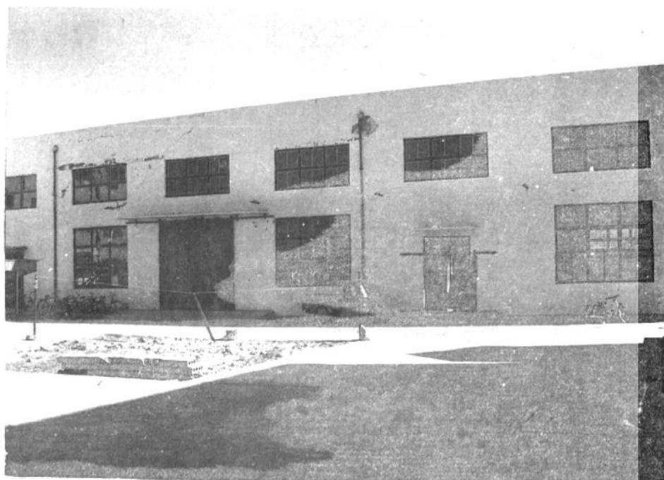
烟台锅炉水汽暖安装工程公司机加工车间
