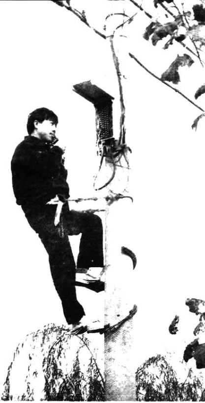
机线员在作业
