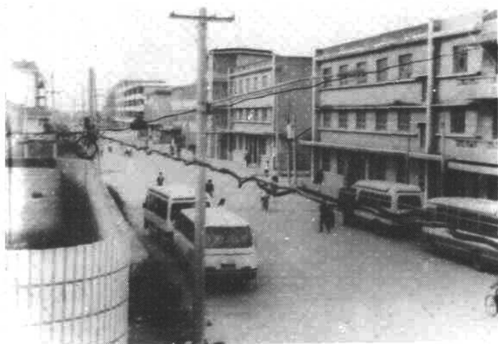
改建后的金塘岛公路
