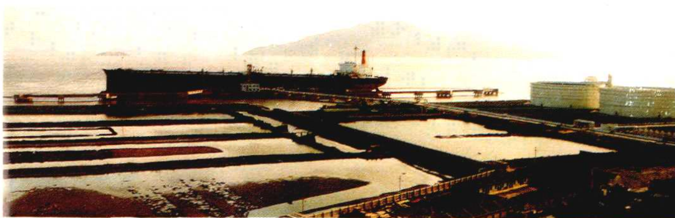
岙山石油转运基地 25 万吨级原油码头
