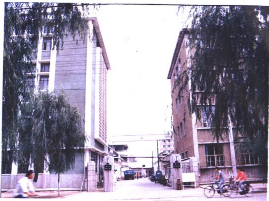
锦州制药二厂厂区建设
