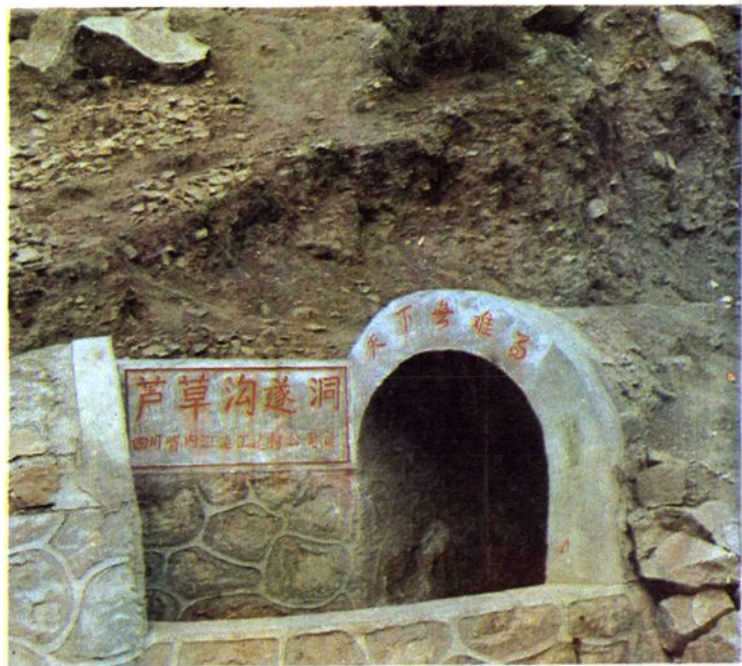
团结干渠芦苇沟隧洞
