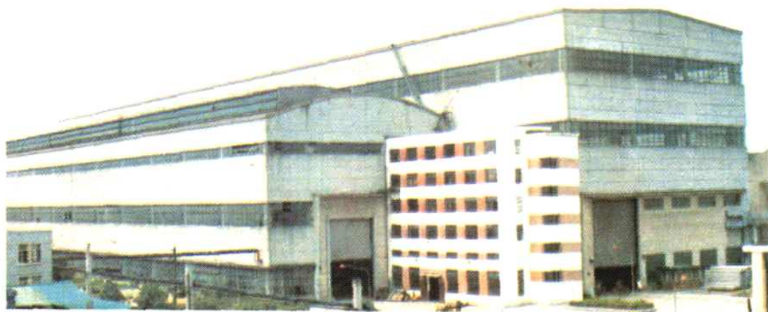
獲國家優秀設計銀質獎“上海鍋爐廠鋼結構重型廠房”（跨度36m, 行車400t）
