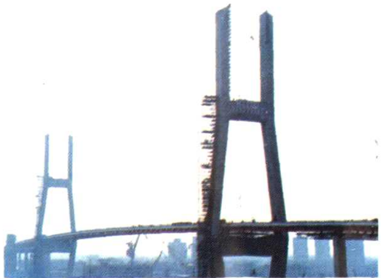
安裝在南浦大橋上的新產品——斜拉索
