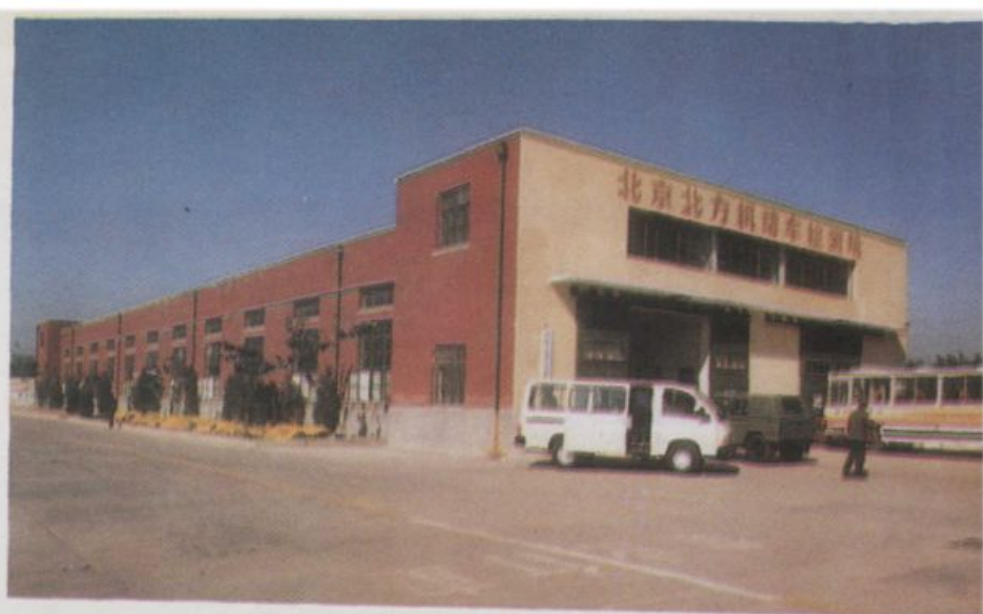
座落在马池口的北方机动车检测场汽车检测车间一角
