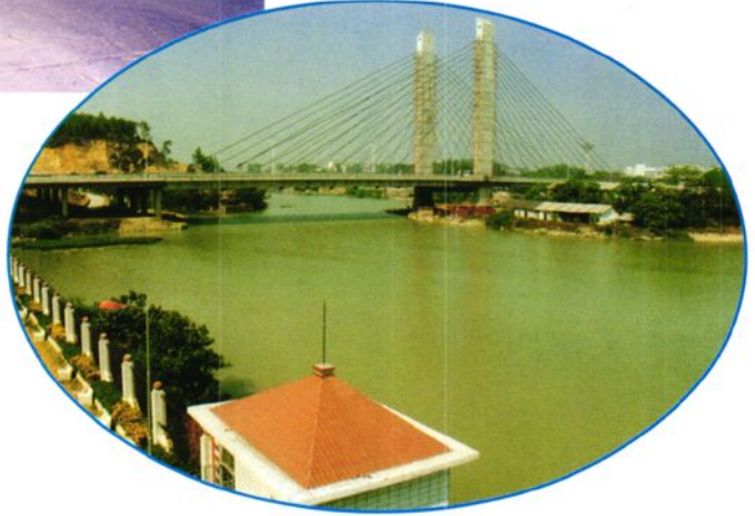
新广花公路流溪河大桥
