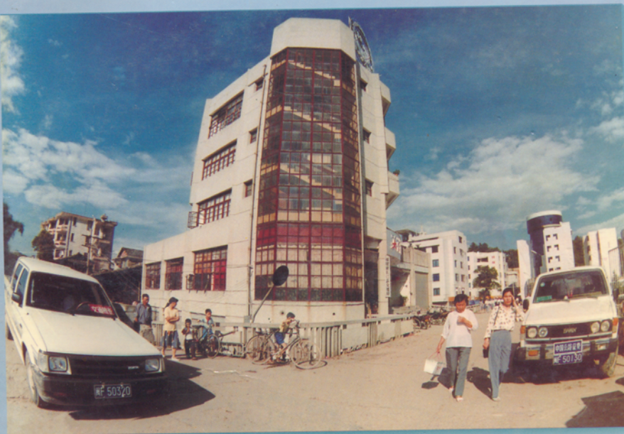
长汀县交通大楼
