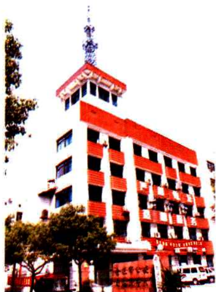
市公安交巡（特） 警大队办公楼（临平 镇梅堰路5号）
