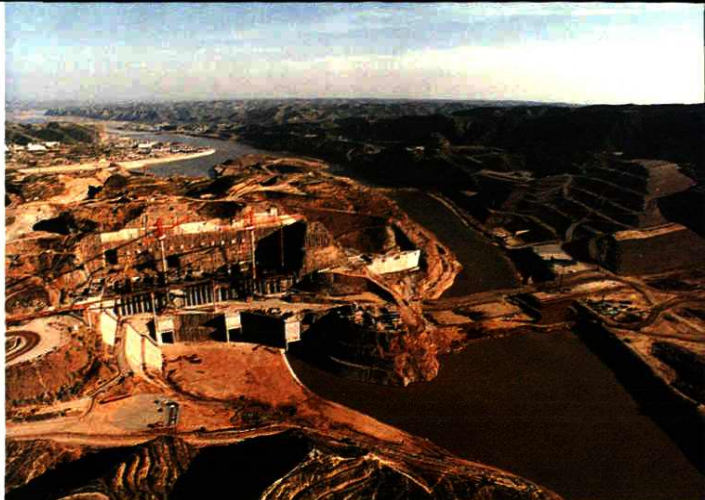
小浪底水利枢纽施工区全景（梁君 摄）
