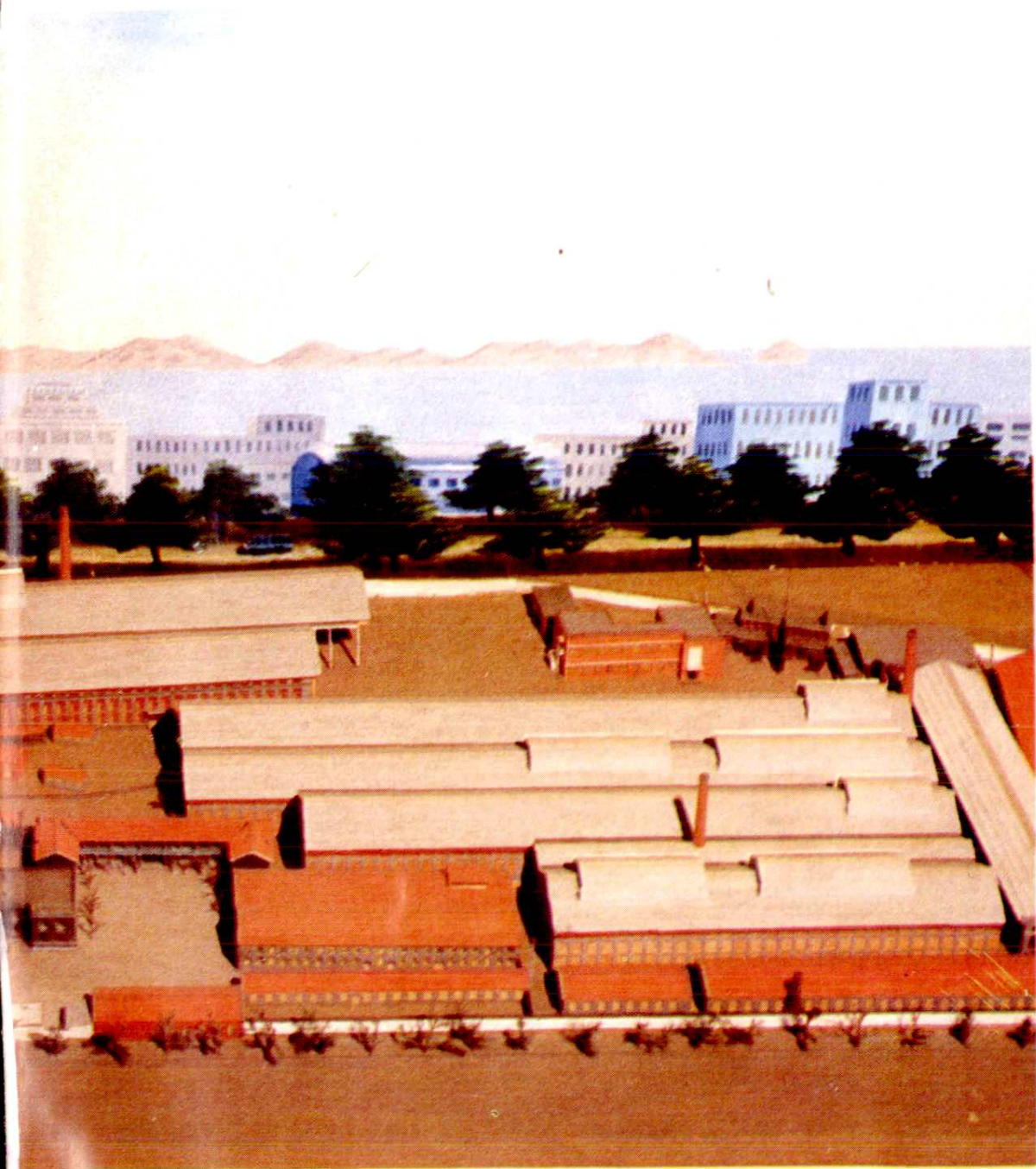
钢管厂厂区鸟瞰图 一九八五年
