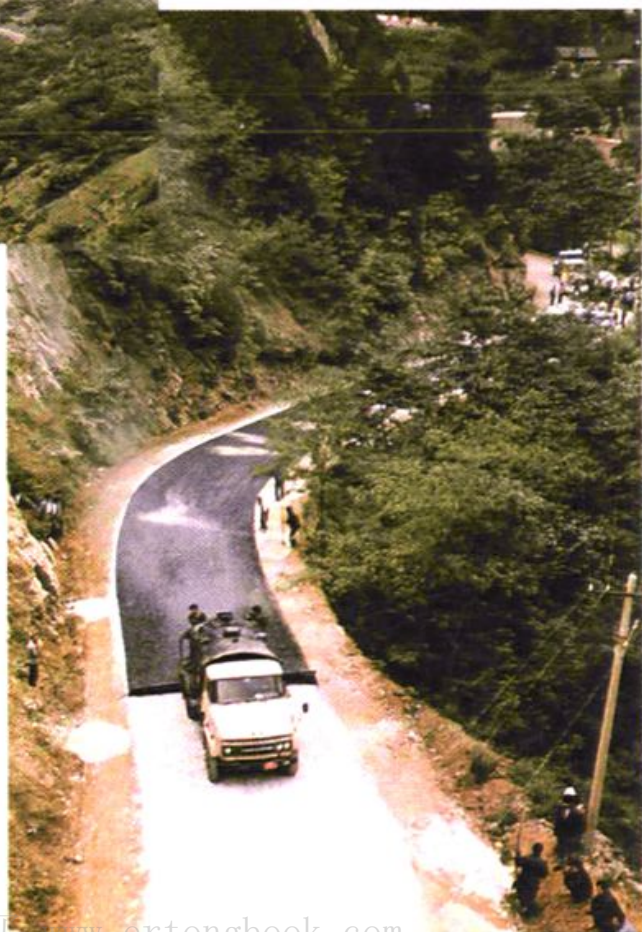
铺修公路黑色路面
