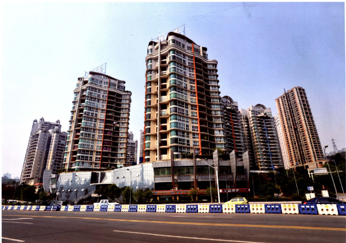
东方港湾边坡和隧道工程勘察
