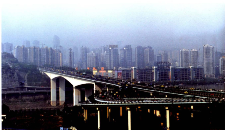
嘉华大桥详勘
