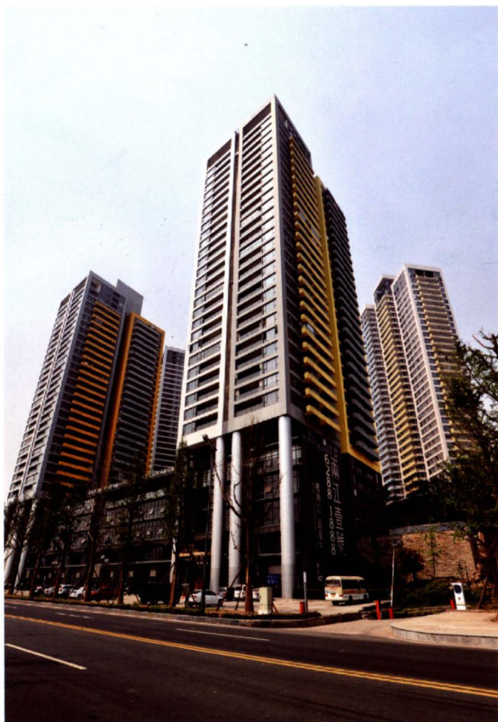
南滨路阳光100工程勘察
