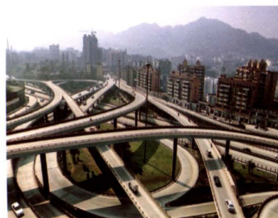
杨公桥立交工程勘察
