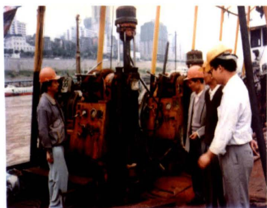
长江过江隧道水上钻探
