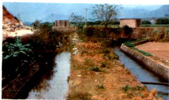
官陂、杜陂渠道口
