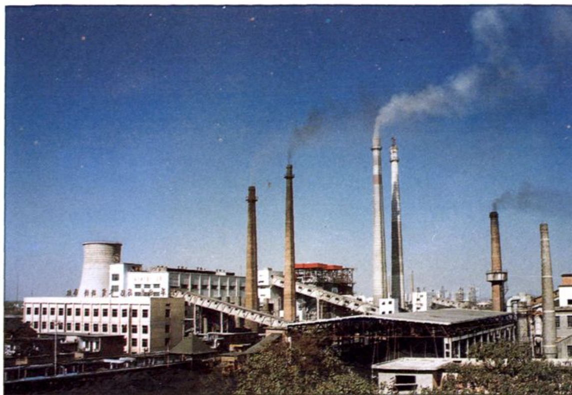
△ 顶城市热电厂
