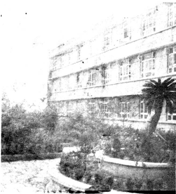
四川省养猪研究所科研大楼
