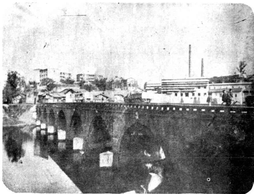
施济桥横跨濑溪河岸，始建于宋代。结构精密，工艺细致，为成渝公路上主要桥梁之一。
