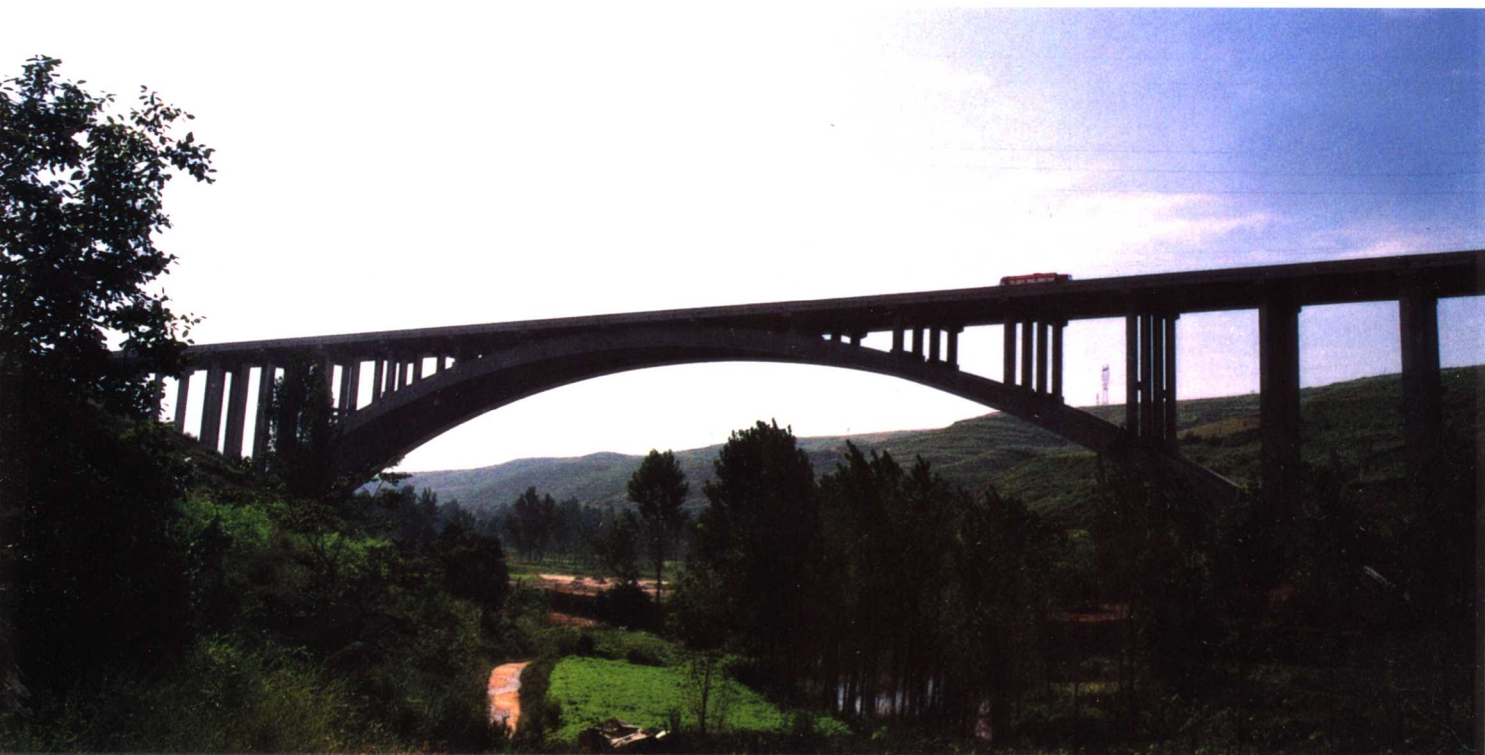
连霍高速公路许沟特大桥，单孔220米，在国内同类桥梁中跨径最大
