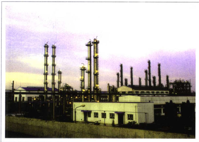
义马气化厂生产区
