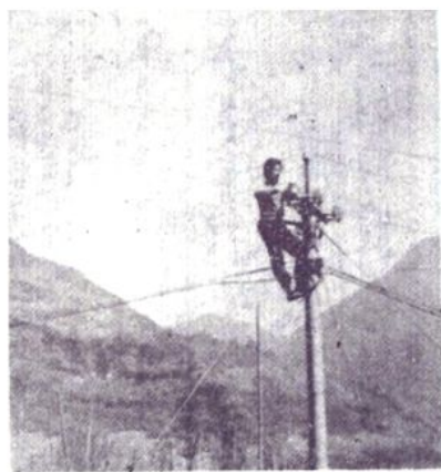
农话机线员在杆上作业
