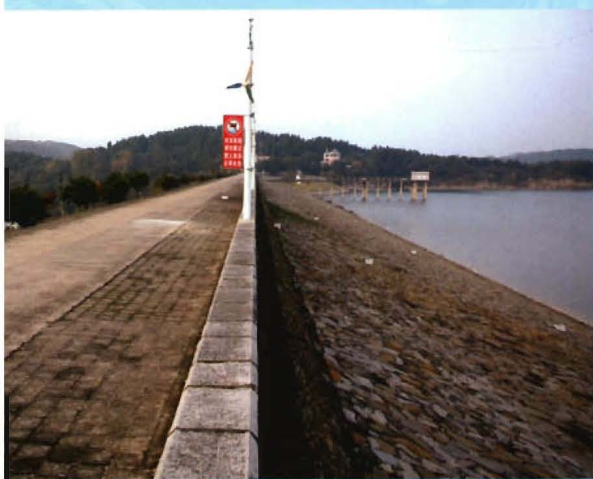
漳河水库大坝
