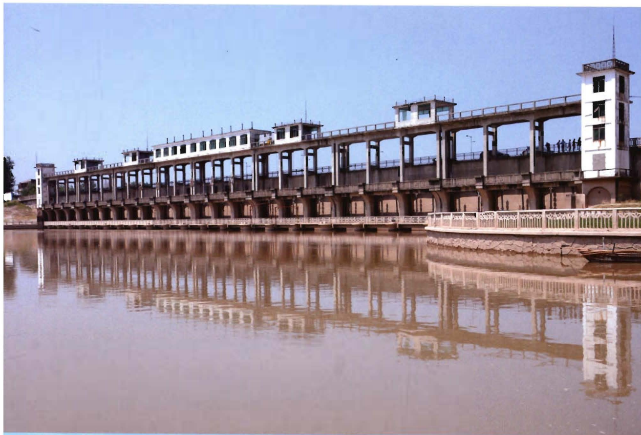
洪湖新堤排水闸
