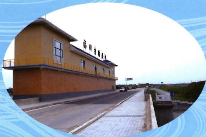
福田寺防洪闸
