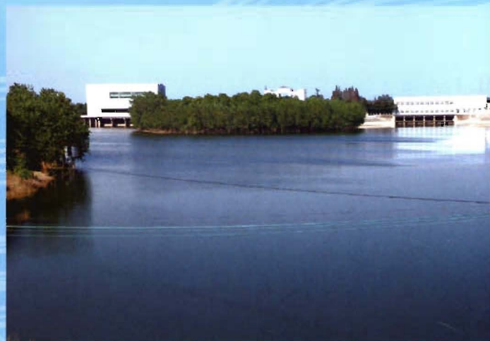
公安闸口二站
