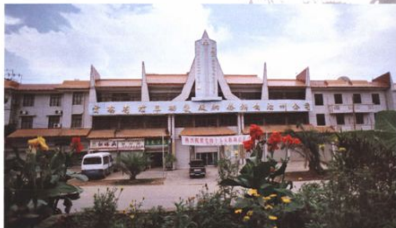
■ 1994年建成的州烟草专卖局（公司）办公楼外景
