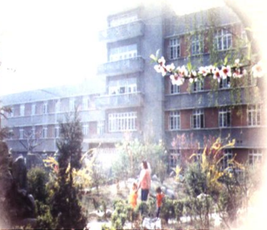
老病房大楼(1984年)
