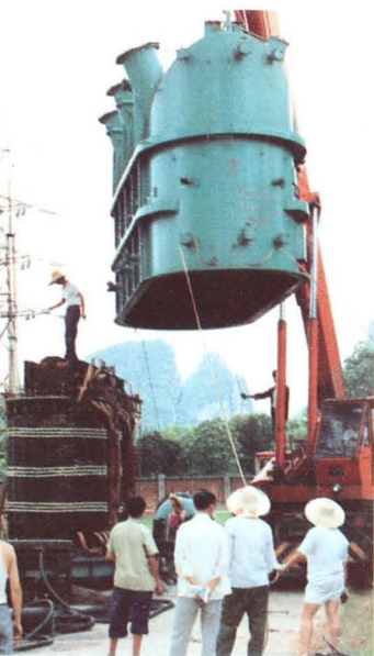
左图 修试车间 工人对北门变电站 变进行吊芯检查
