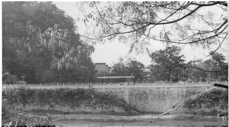
1916年创 办的桂林电灯 公司象鼻山发 电厂船岸遗址
