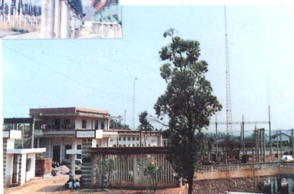
110千伏荔浦县变 电站容量2万千伏安
