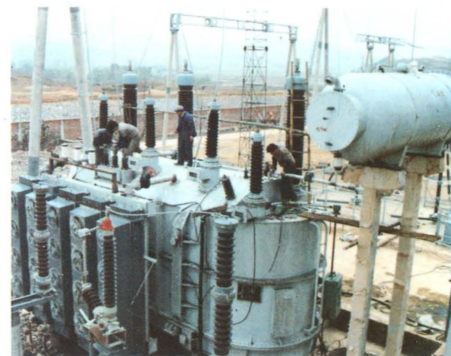
220千伏巖村变电站二期工 程在安装主变容量9万千瓦安
