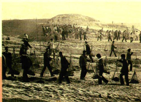
“91.7”洪灾后, 闵集石马槽农民在修筑河堤
