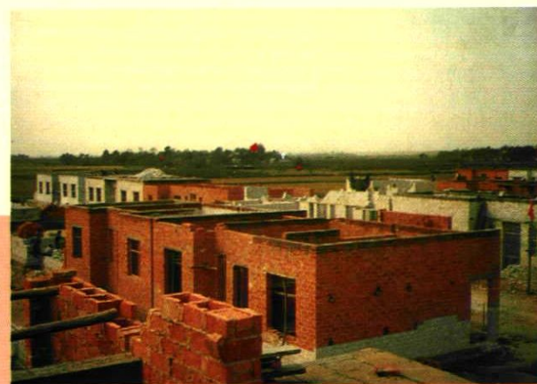
“91.7”洪灾后，政府拨款帮助倒房农民重建楼房， 图为闵集乡雨阴河村建房工地
