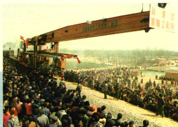
京九铁路正在紧张铺轨
