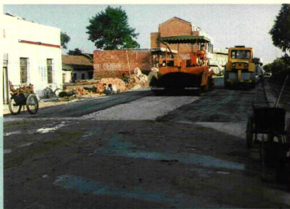
交通局工程队正在106国道紧张铺设沥青路面
