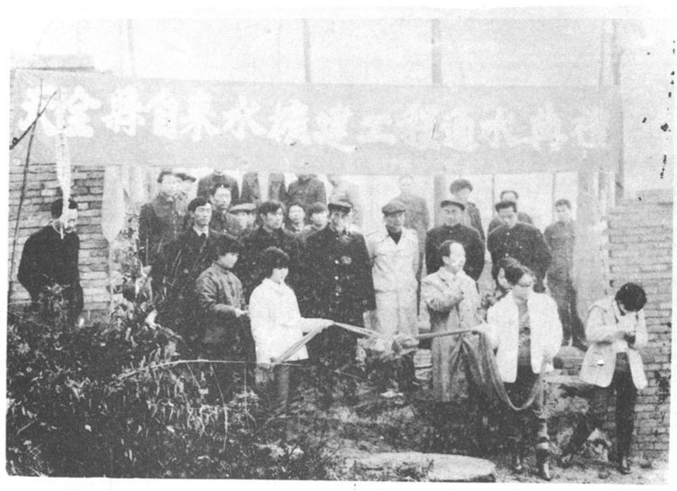
自来水扩建工程通水
