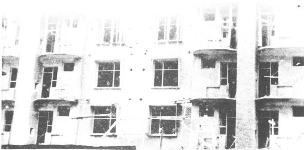
修建中的天全县城乡建设环境保护局新建办公大楼
