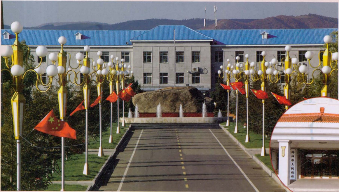
中共海林市委、市人民政府办公楼
