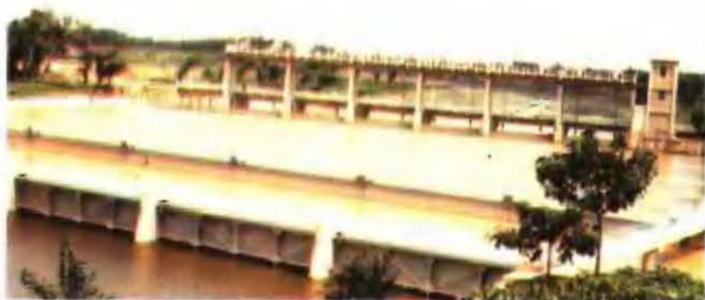
位山引黄灌区三千渠王堤口渡槽
