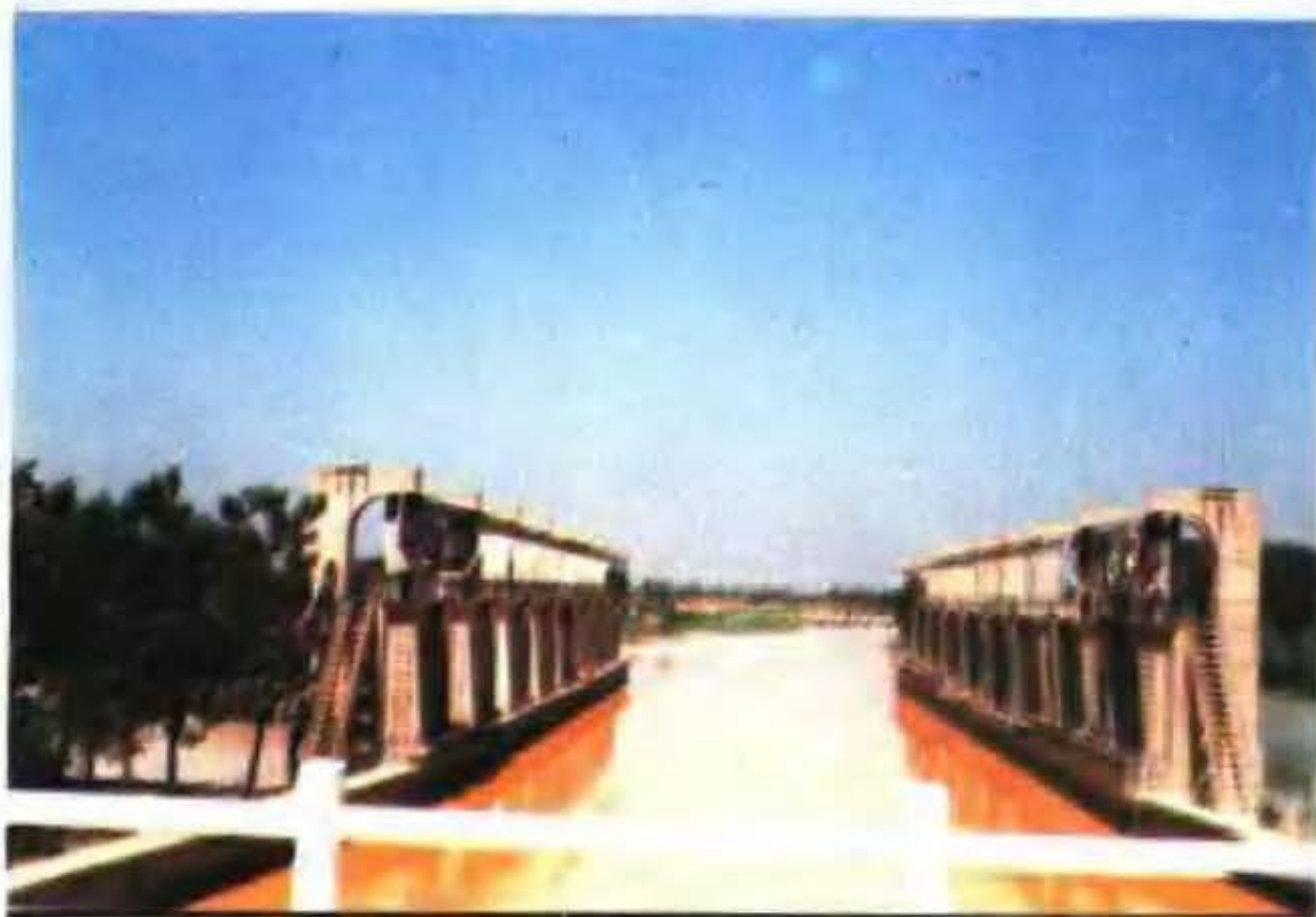
位山引黄灌区三千渠王铺渡槽
