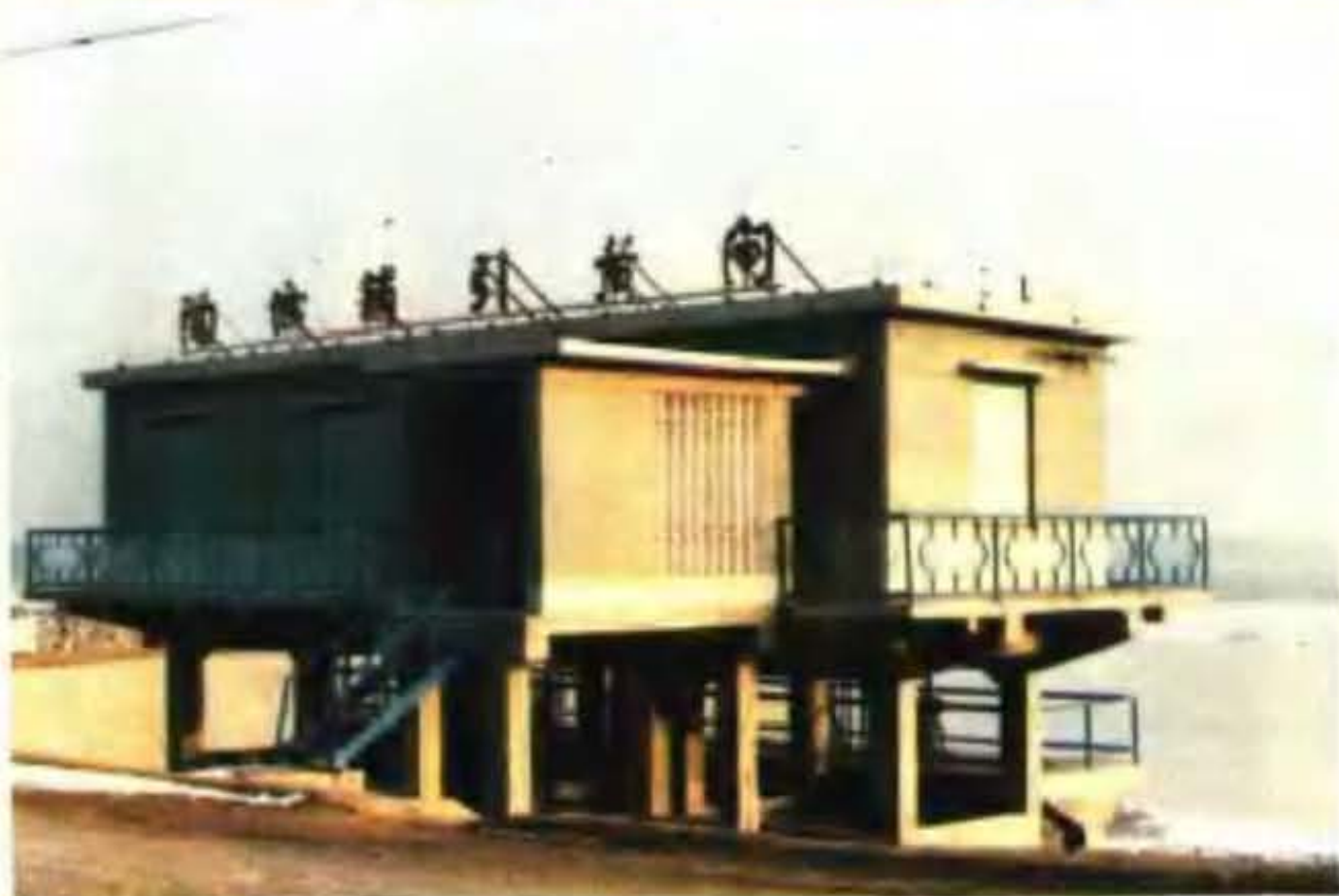
陶城铺引黄灌区渠首闸
