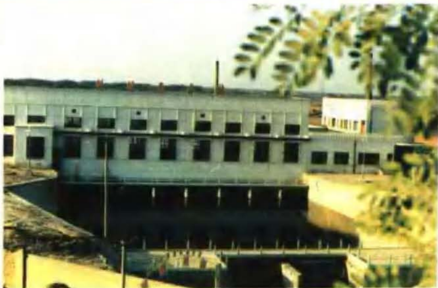
陶城铺引黄灌区骆驼巷泵站
